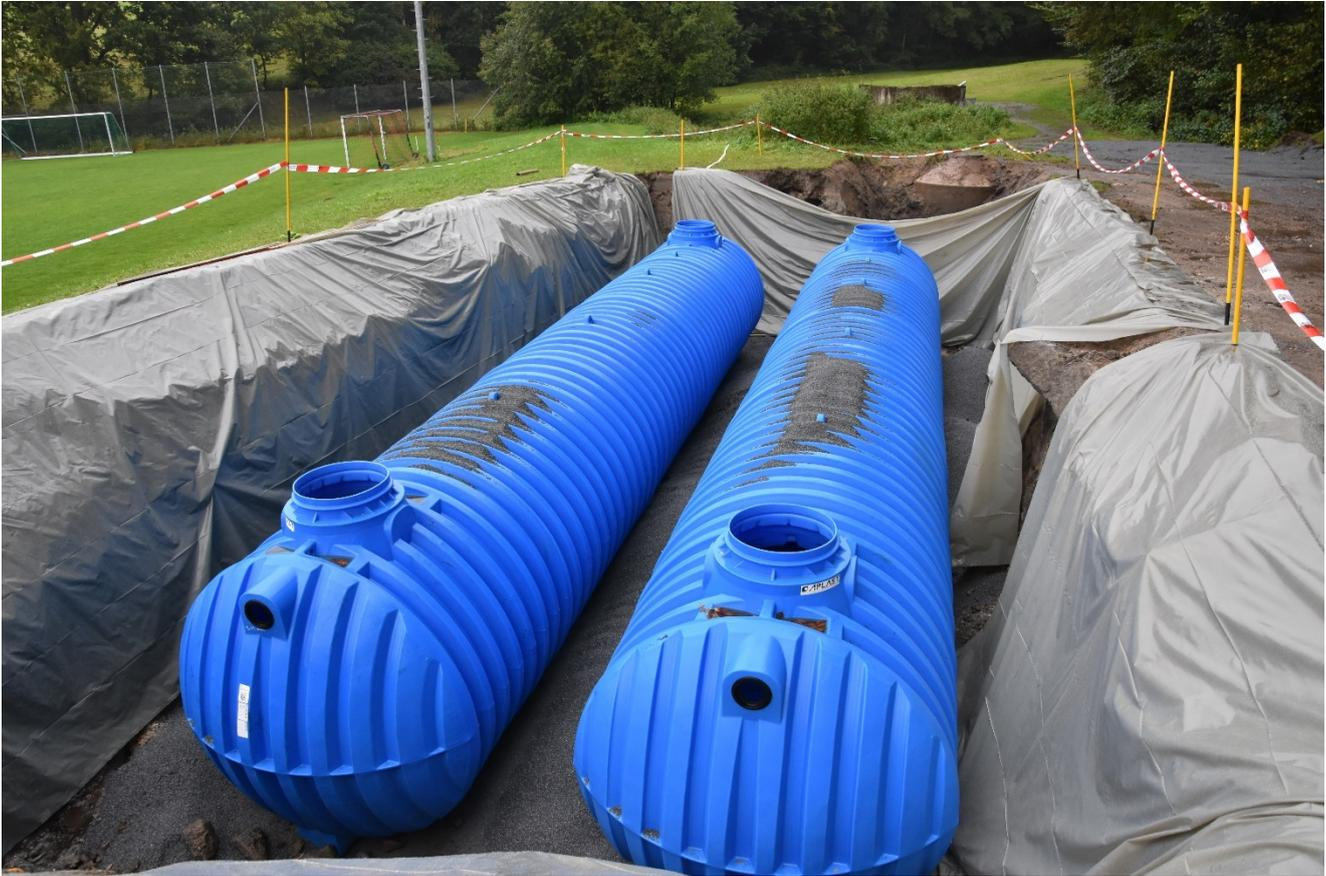
**Zwei Tanks mit je 50000 Liter Füllvermögen wurden an das bestehende Bewässerungssystem angeschlossen.**
